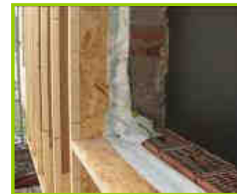
Renovatie, De Pinte, A. Versele
